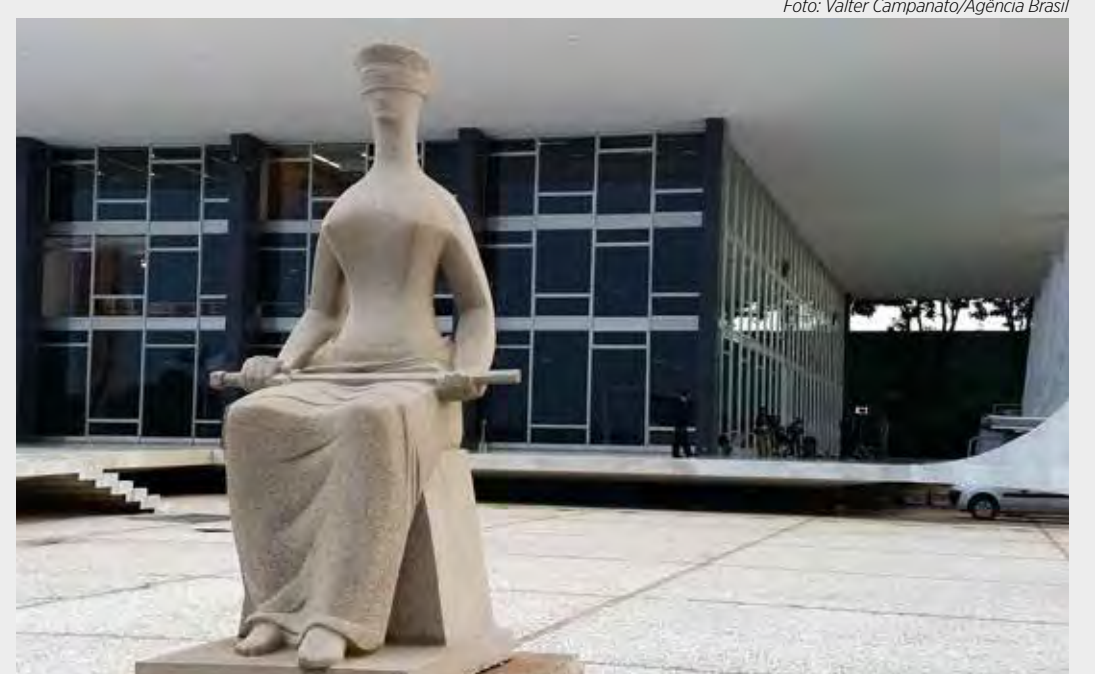
Fachada do prédio do O Supremo Tribunal Federal (STF), em Brasília
