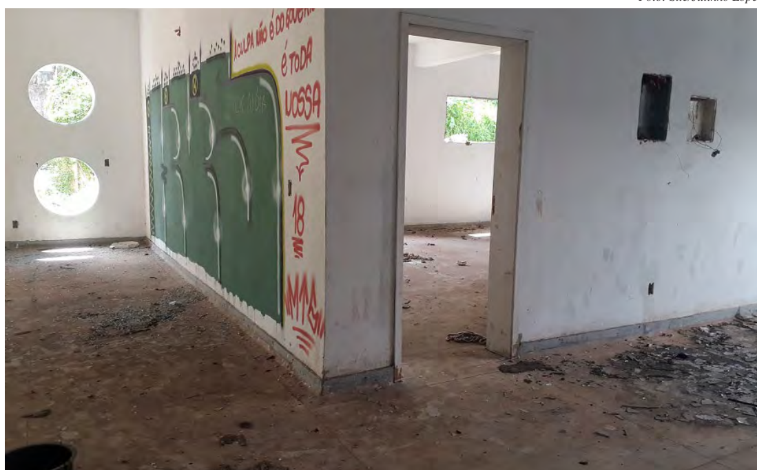
Prédio da escola Sueli Marin cuja obra será retomada
