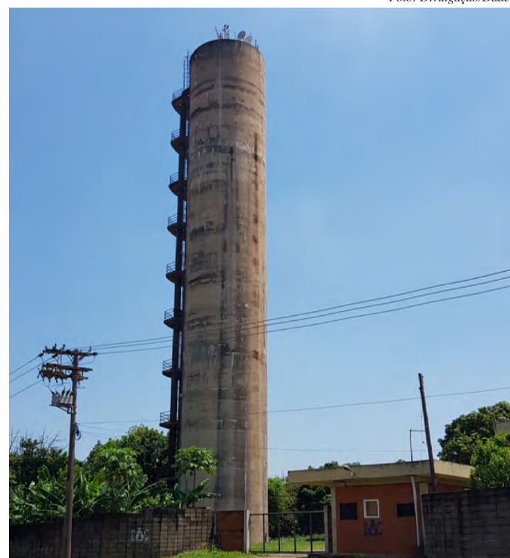
Central de distribuição de água será desligada para troca de transformadores
