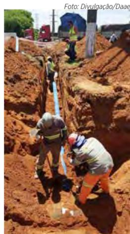
para proteção e acesso a esse equipamento. Já foi feita a limpeza e higienização da nova tubulação que passa por testes para interligação na rede existente nos próximos dias. (Fonte: Divulgação/Daae)
