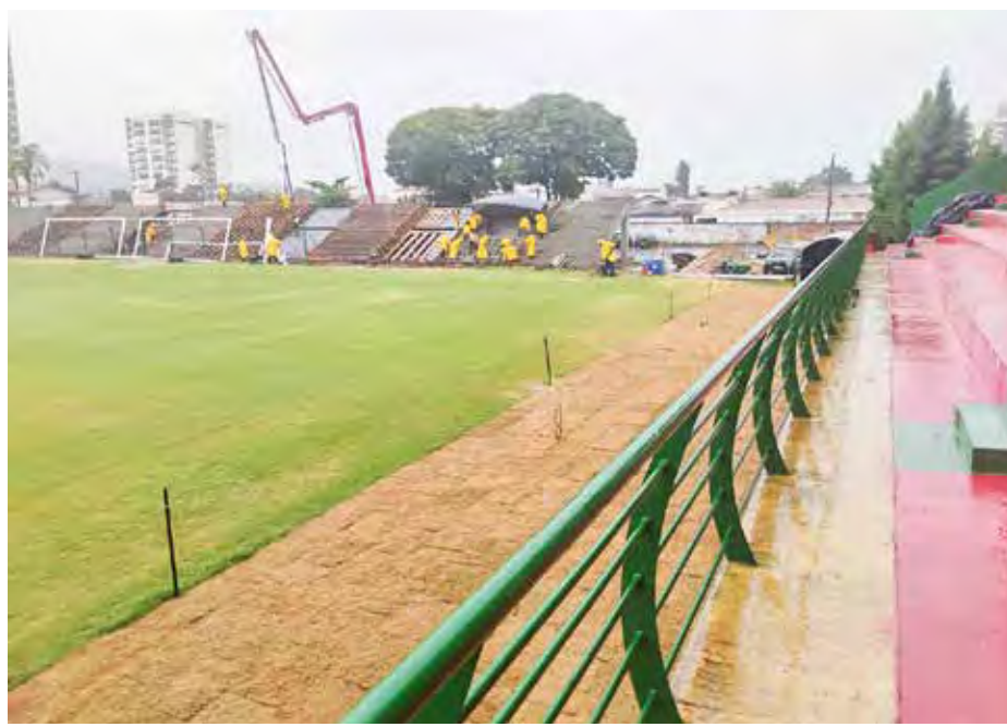
Nova arquibancada do estádio Benitão está perto de ser finalizada
