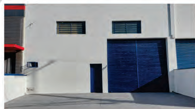
CÓDIGO 9121 Galpão 300,00 M2, contendo recuo para carros, escritório, mezanino, 2 Wc's, cozinha, área de luz. Avenida 14 Nº 2227, Jardim São Paulo - Rio Claro Valor: R$900.000,00
