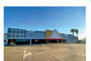
Código 8262 ÁREA TERRENO: 4.269,12 M2 - ÁREA CONSTRUÍDA: 2.513,00 M2 - Centro- Rio Claro - Valor Locação: R$94.444,44
