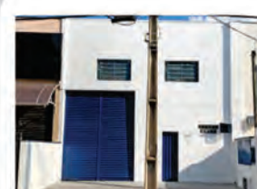
CÓDIGO 9122 Galpão 300,00 M2, contendo recuo para carros, escritório, mezanino, 2 Wc's, cozinha, área de luz. Avenida 14 Nº 2237, Jardim São Paulo - Rio Claro Valor: R$5.555,55
