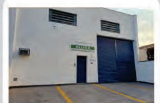
CÓDIGO 9123 Galpão 300,00 M2, contendo recuo para carros, escritório, mezanino, 2 Wc's, cozinha, área de luz. Avenida 14 Nº 2247, Jardim São Paulo - Rio Claro Valor: R$5.555,55
