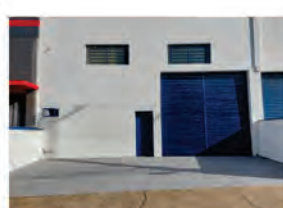
CÓDIGO 9121 Galpão 300,00 M2, contendo recuo para carros, escritório, mezanino, 2 Wc's, cozinha, área de luz. Avenida 14 Nº 2227, Jardim São Paulo - Rio Claro Valor: R$5.555,55
