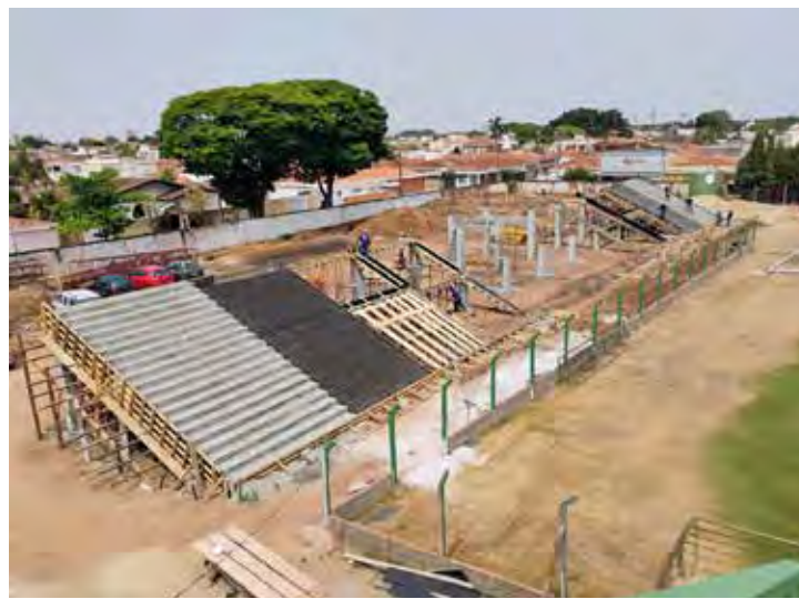
Nova arquibancada já recebe concretagem
