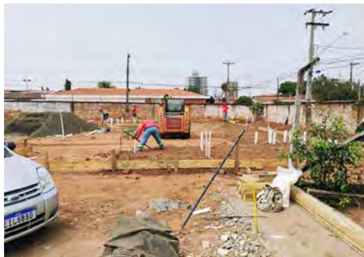
Operários trabalham na construção da nova sede administrativa do estádio Benitão
