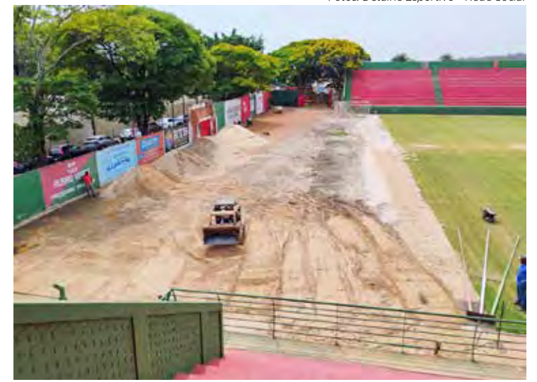
Mini campo está sendo construído no lado da Avenida 19
