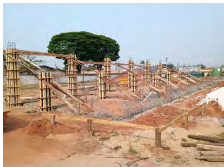
Construção da nova arquibancada do Benitão segue em ritmo acelerado
