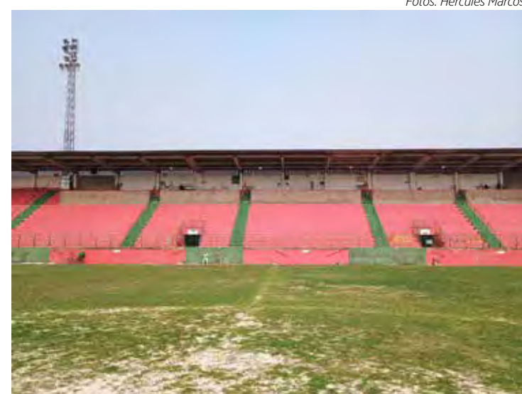
Novas cabines de imprensa estão sendo construídas na arquibancada coberta
