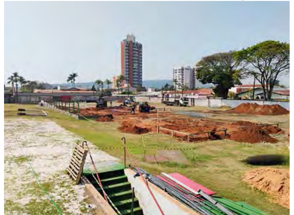
Vista parcial das obras no Benitão
