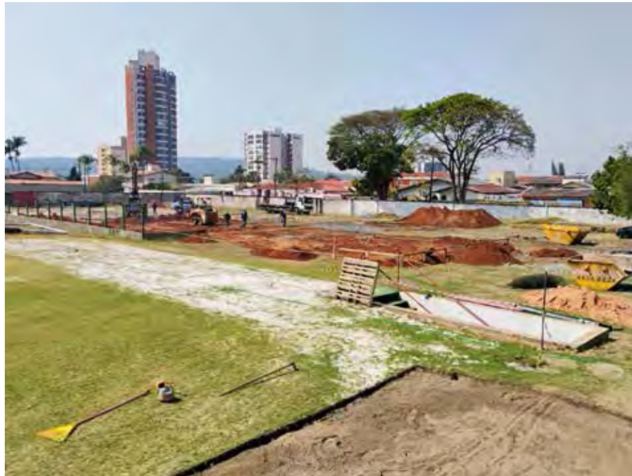
Operários e máquinas trabalham na edificação da nova arquibancada
