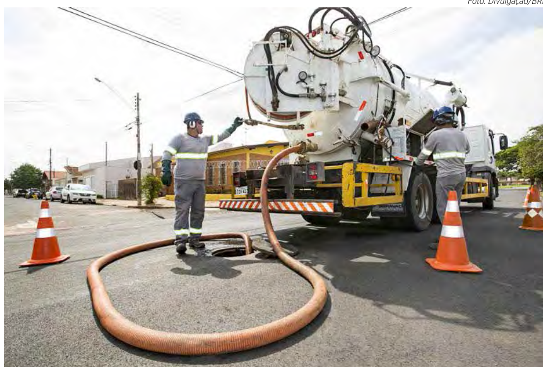
Serviço de lavagem preventiva da rede de esgoto
