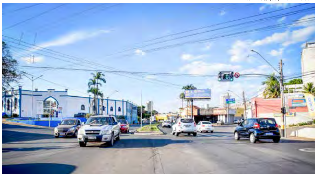
Avenida Visconde do Rio Claro terá nova etapa de obras
