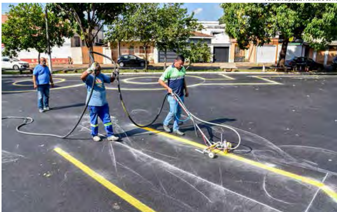
O trabalho de pintura de sinalização de trânsito melhora a organização do trânsito
