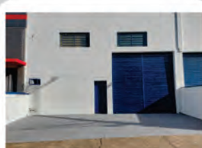
CÓDIGO 9121 Galpão 300,00 M2, contendo recuo para carros, escritório, mezanino, 2 Wc's, cozinha, área de luz. Avenida 14 Nº 2227, Jardim São Paulo - Rio Claro Valor: R$835.000,00
