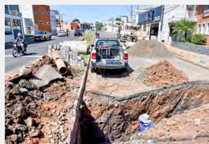
Serviços estão sendo realizados pela prefeitura
