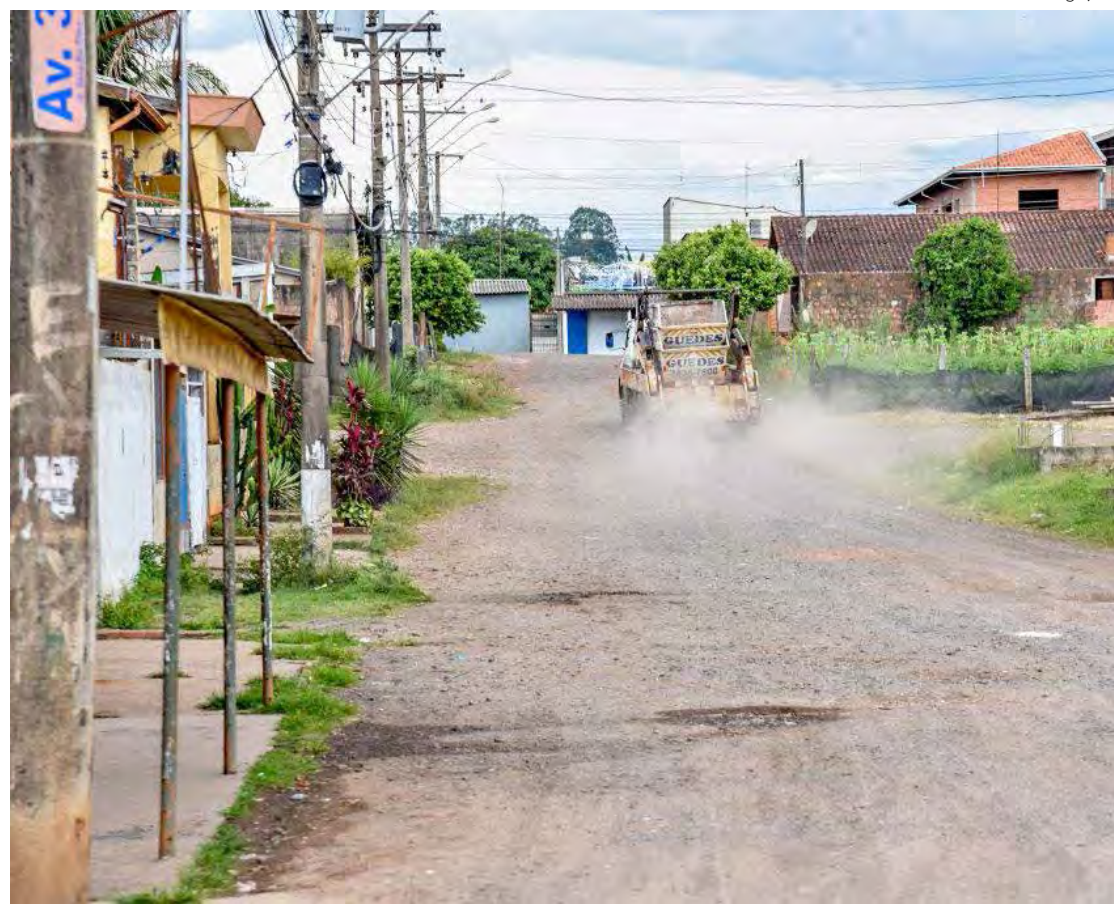
Rua sem asfalto no Jardim Nova Rio Claro cujos moradores aguardam há anos a pavimentação
