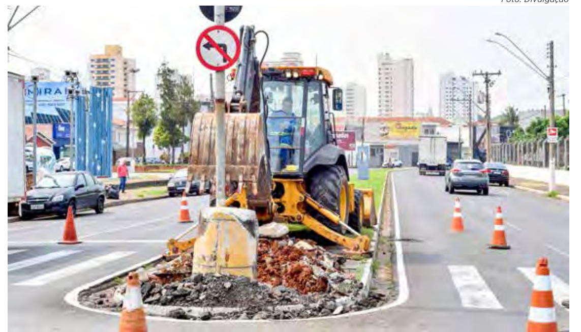
Canteiros centrais estão sendo removidos para implantação de via exclusiva para ciclistas
