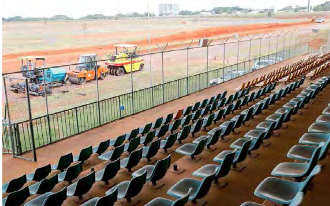
Autódromo de Brasília passa por obras
