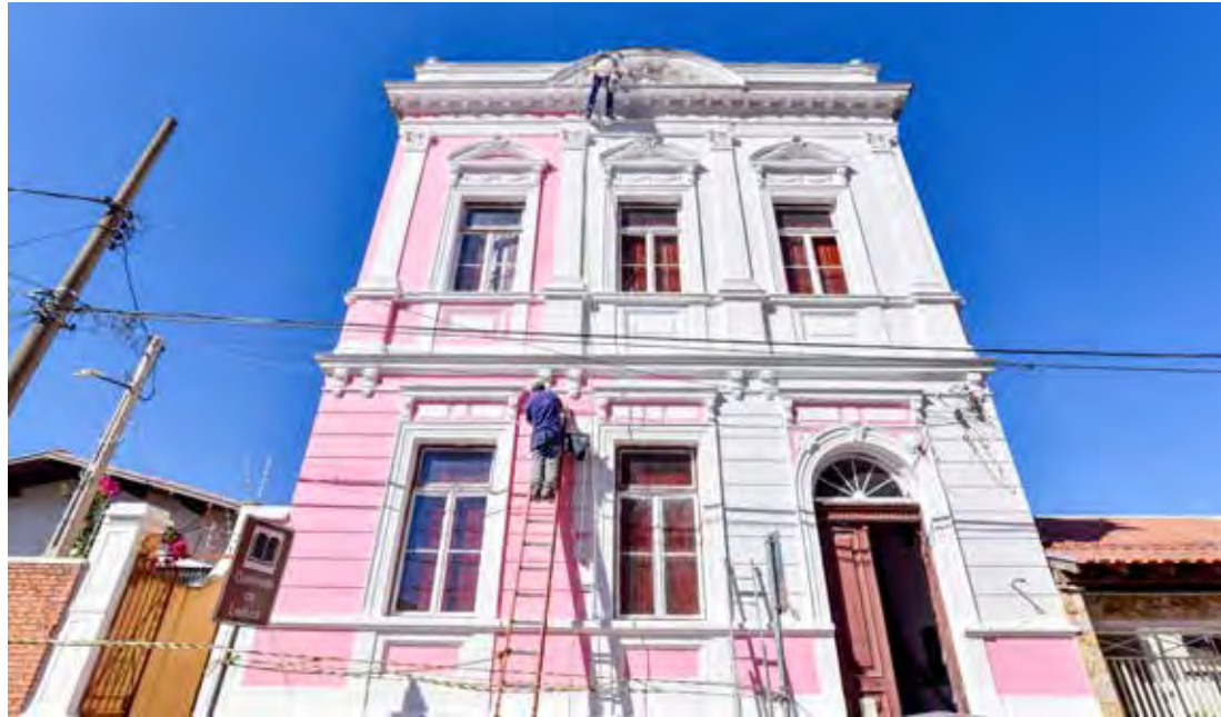
Prédio do Gabinete de Leitura está recebendo melhorias.
