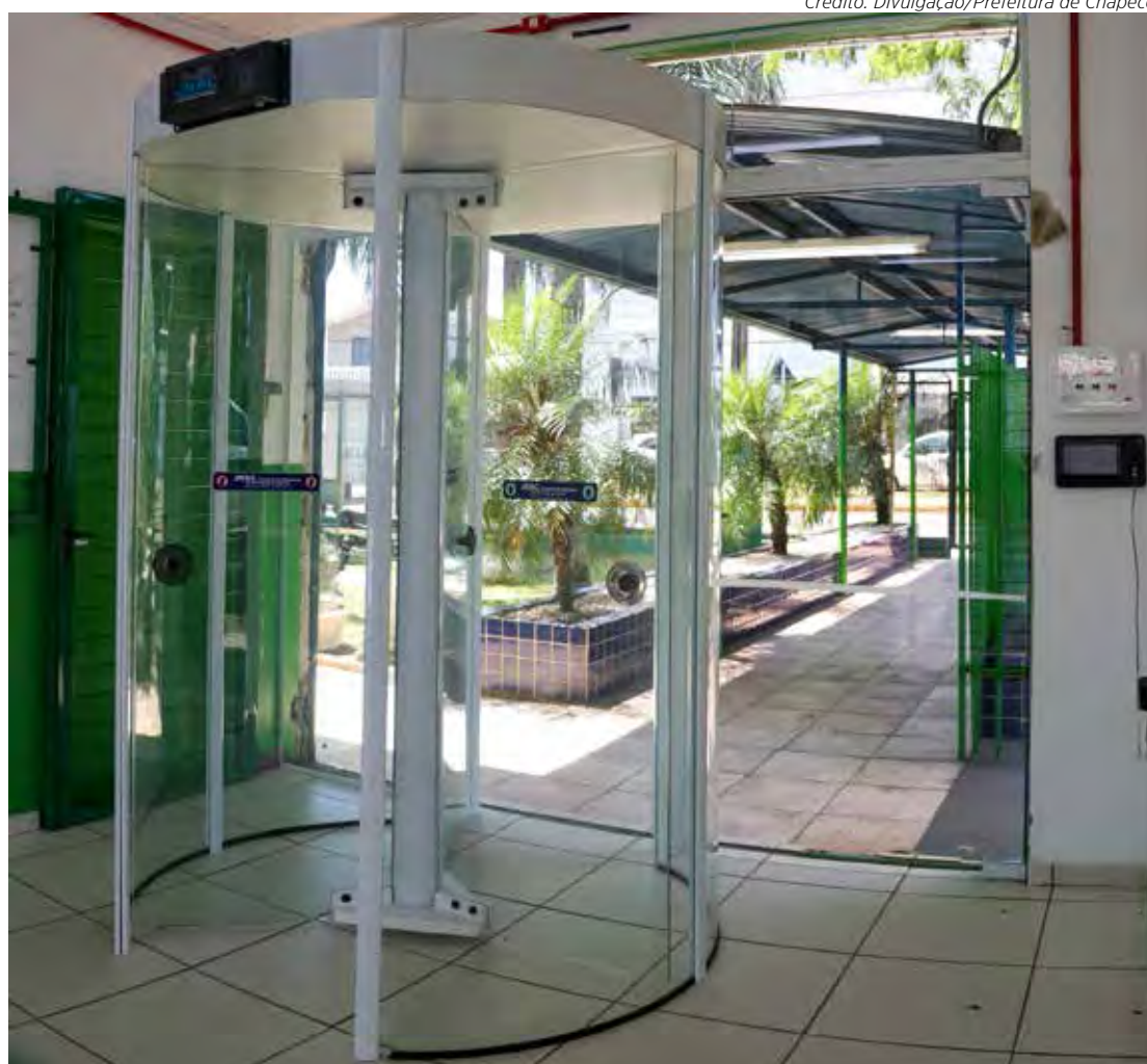
Portas com detectores de metal estão sendo instaladas em escolas do município de Chapecó (SC)
