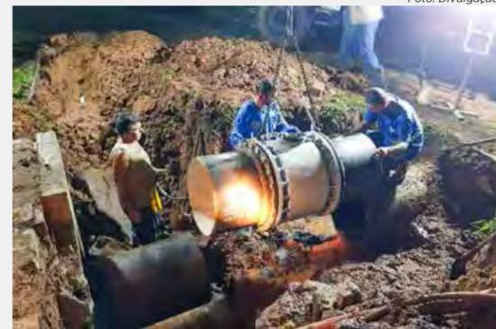
Servidores do Daae fazem instalação do macromedidor na ETA 1
