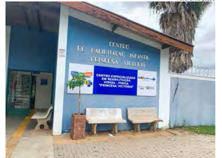
Fachada do Centro Especializado em Reabilitação Princesa Victoria
