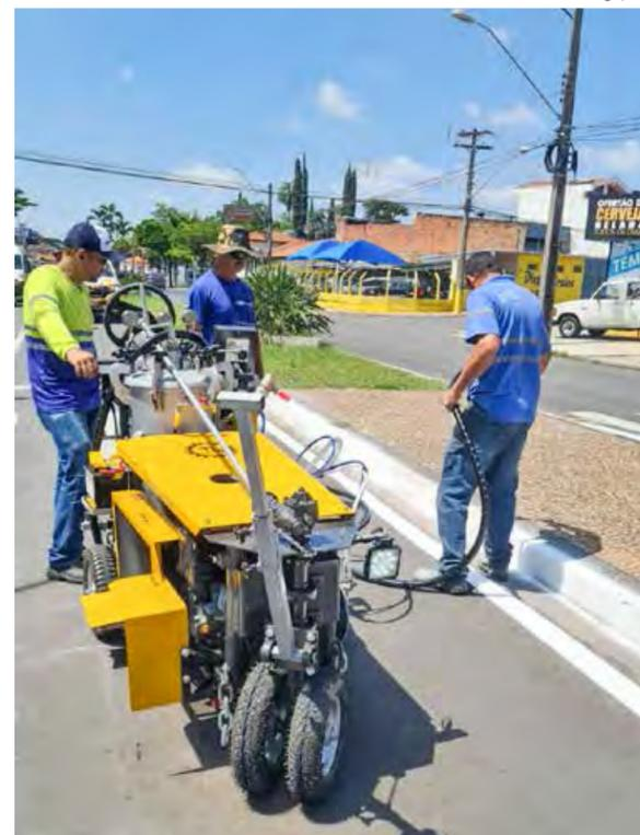
A máquina é acoplada em veículo e conta com pistola de chão e pistola manual
