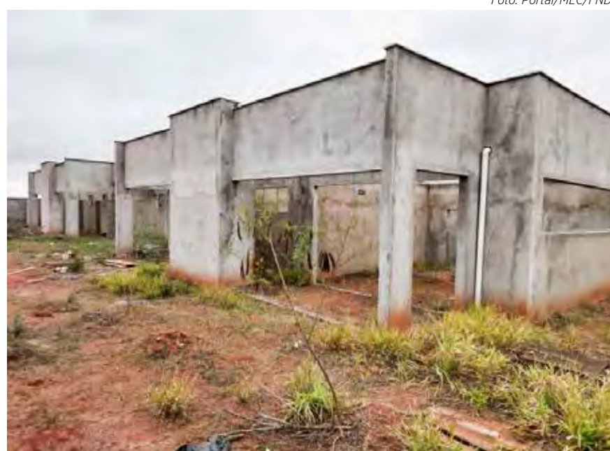
Construção em andamento da creche no Jardim Residencial dos Bosques
