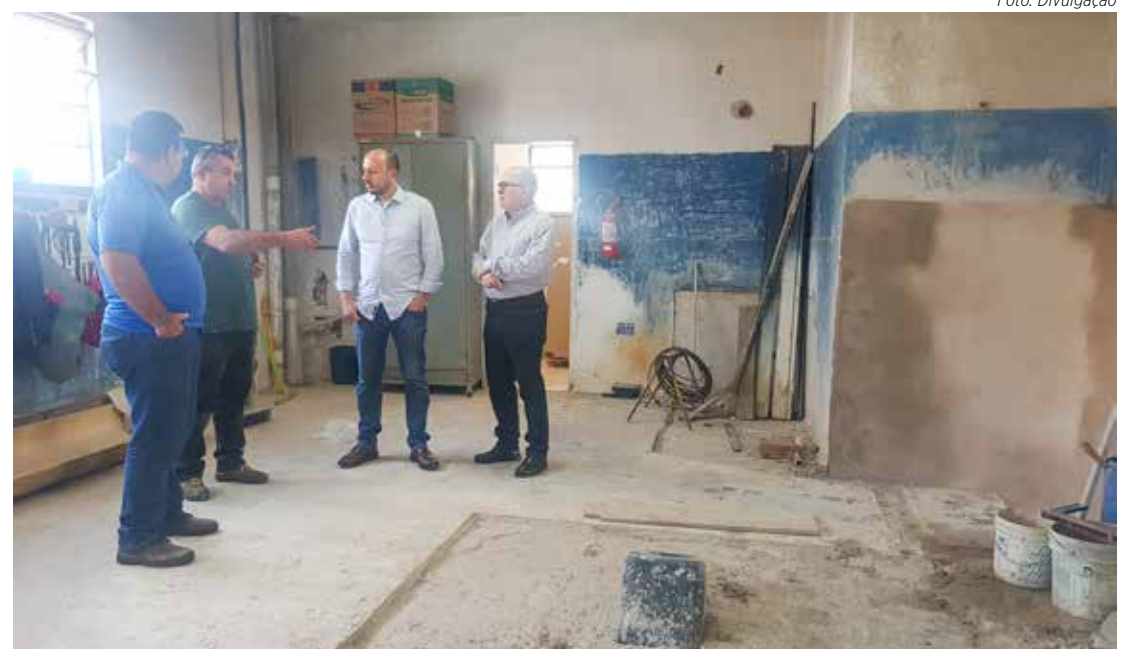
O prefeito Gustavo acompanhou as obras de melhorias na ETA 1
