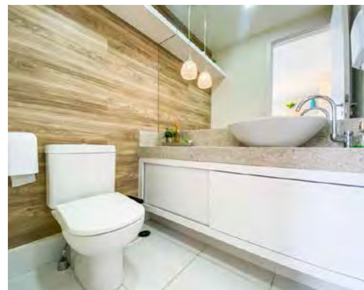
Vinílico instalado na parede do banheiro
