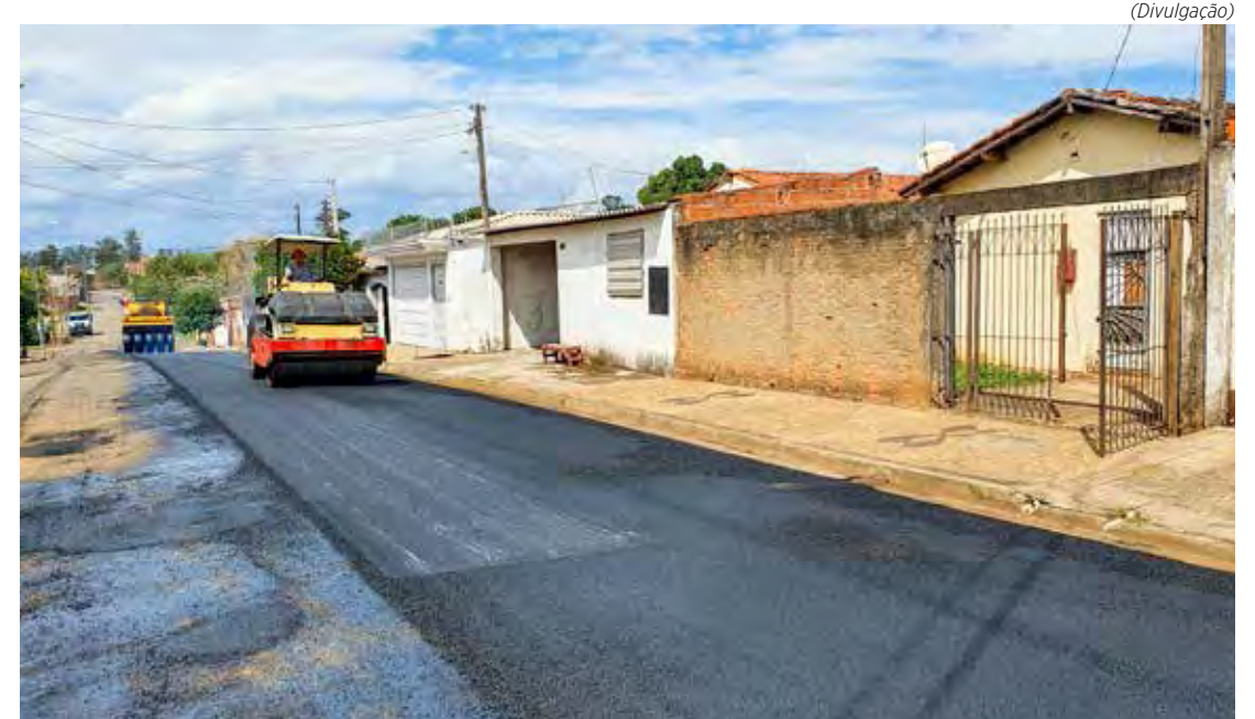
Serviços de melhoria no pavimento asfáltico foram realizados no Jardim Boa Vista
