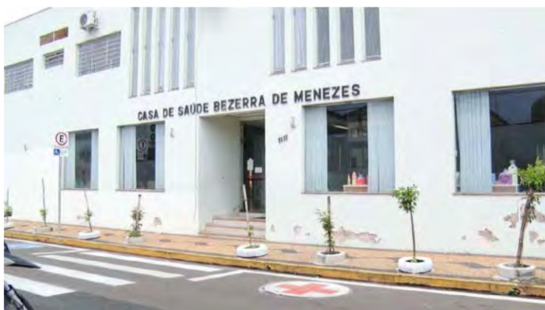
Fachada do prédio Casa de Saúde que fica na Avenida 25, no Bairro do Estádio
