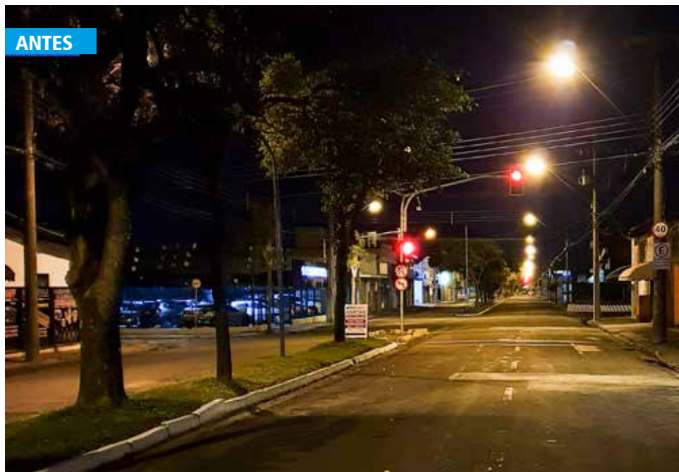
Avenida 50-A, entre a Rua 3-A e a Avenida José Felício Castelano, ganhou nova iluminação
