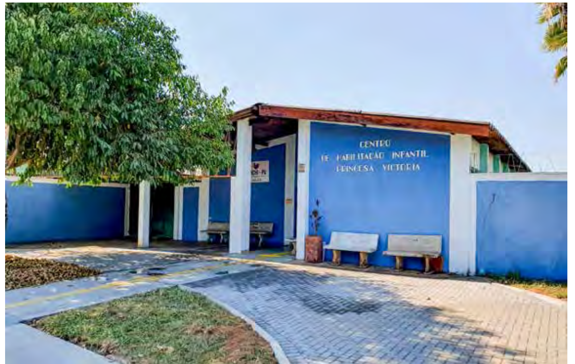
Fachada do prédio Centro Especializado em Reabilitação Princesa Victoria
