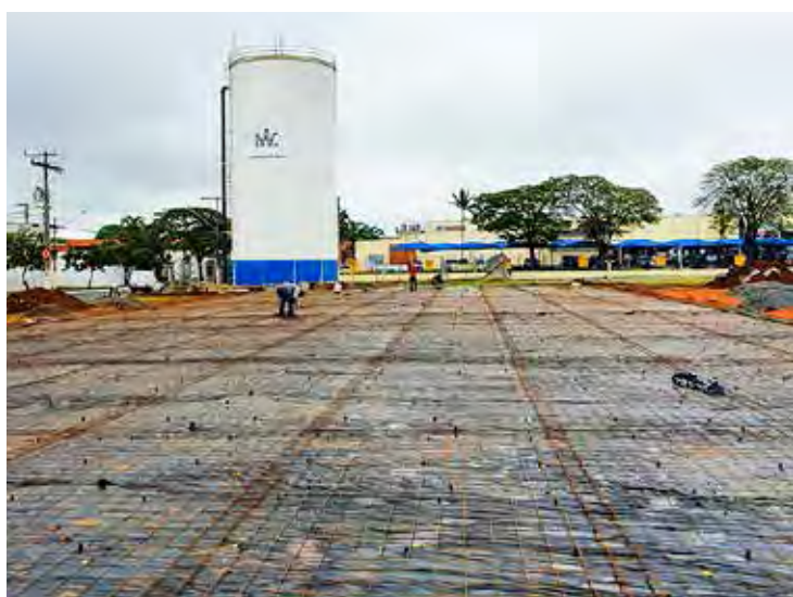
Arena esportiva está sendo construída na Avenida 29, no Bairro do Estádio
