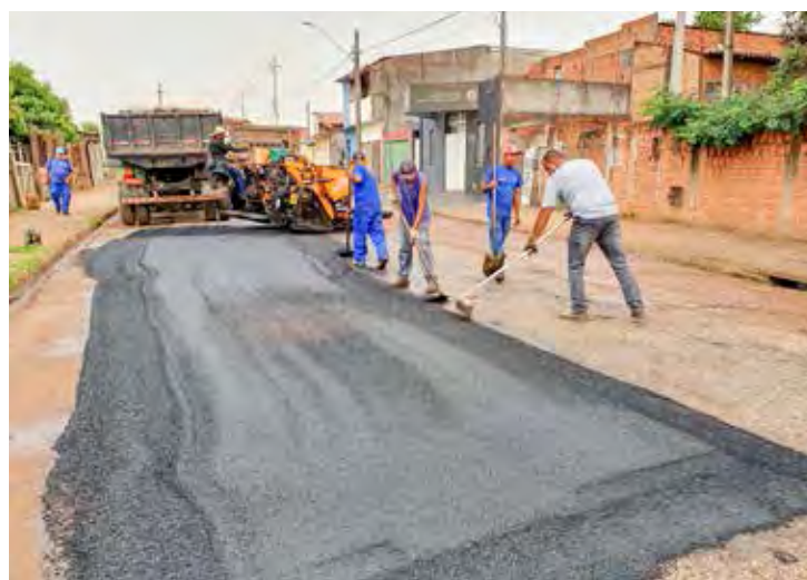
Reparo asfáltico atende os bairros Palmeiras, Terra Nova e Jardim Novo
