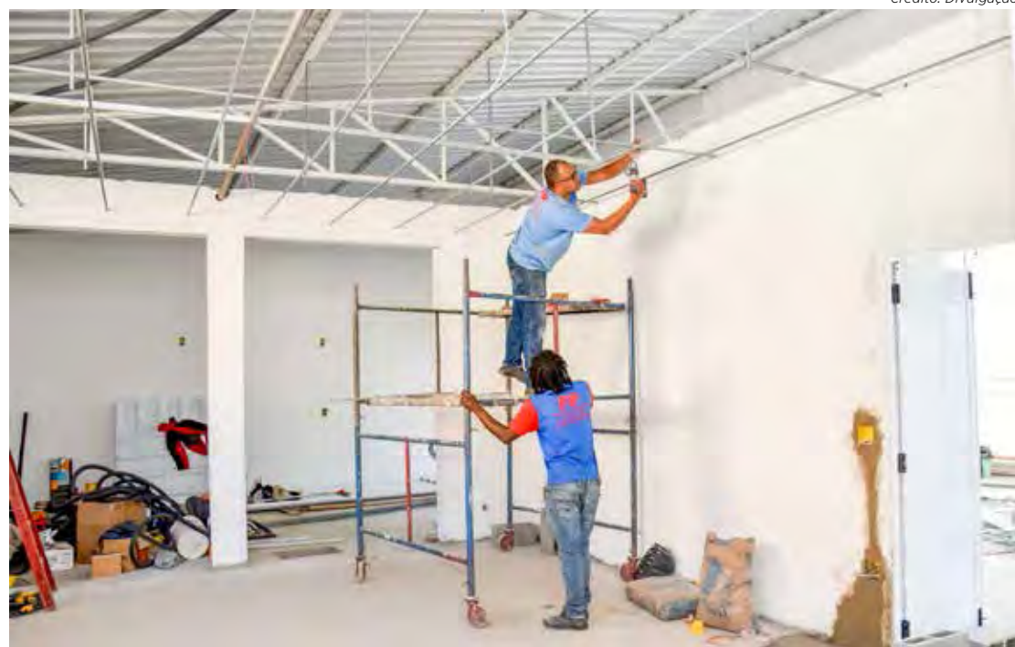
A nova lavanderia está sendo construída na Avenida 31, próximo à unidade de pronto atendimento da Avenida 29
