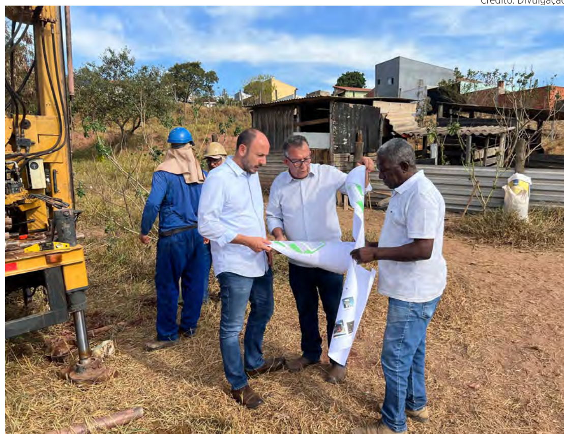
O prefeito Gustavo acompanhou trabalhos de sondagem em três áreas que vão receber as moradias.
