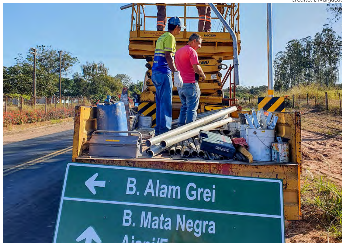
Placas de sinalização estão sendo instaladas na estrada de Ajapi.
