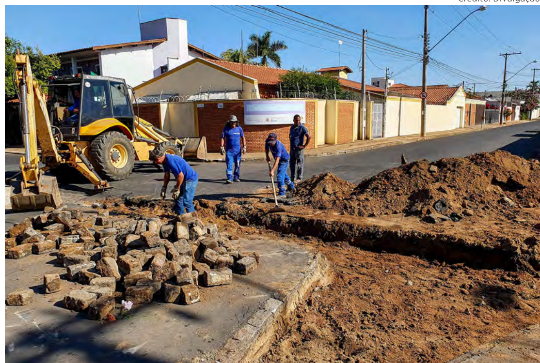
Serviço de suavização de valeta na Rua 8 foi iniciado nesta segunda-feira (4).
