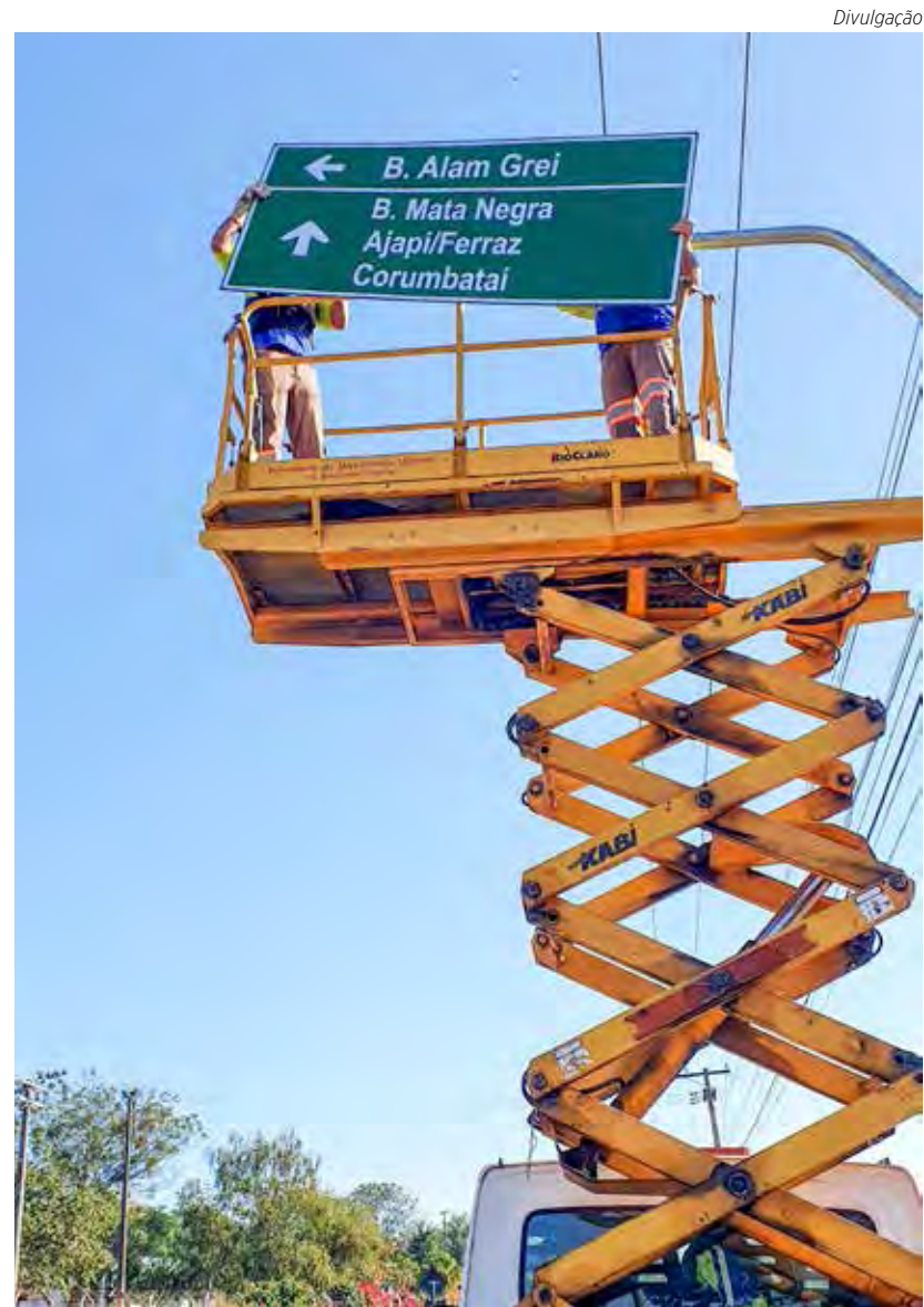
Placas de sinalização estão sendo instaladas na estrada de Ajapi
