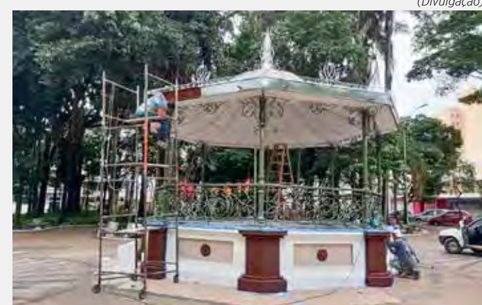
Jardim Público recebe trabalho de limpeza e ajustes nos canteiros
