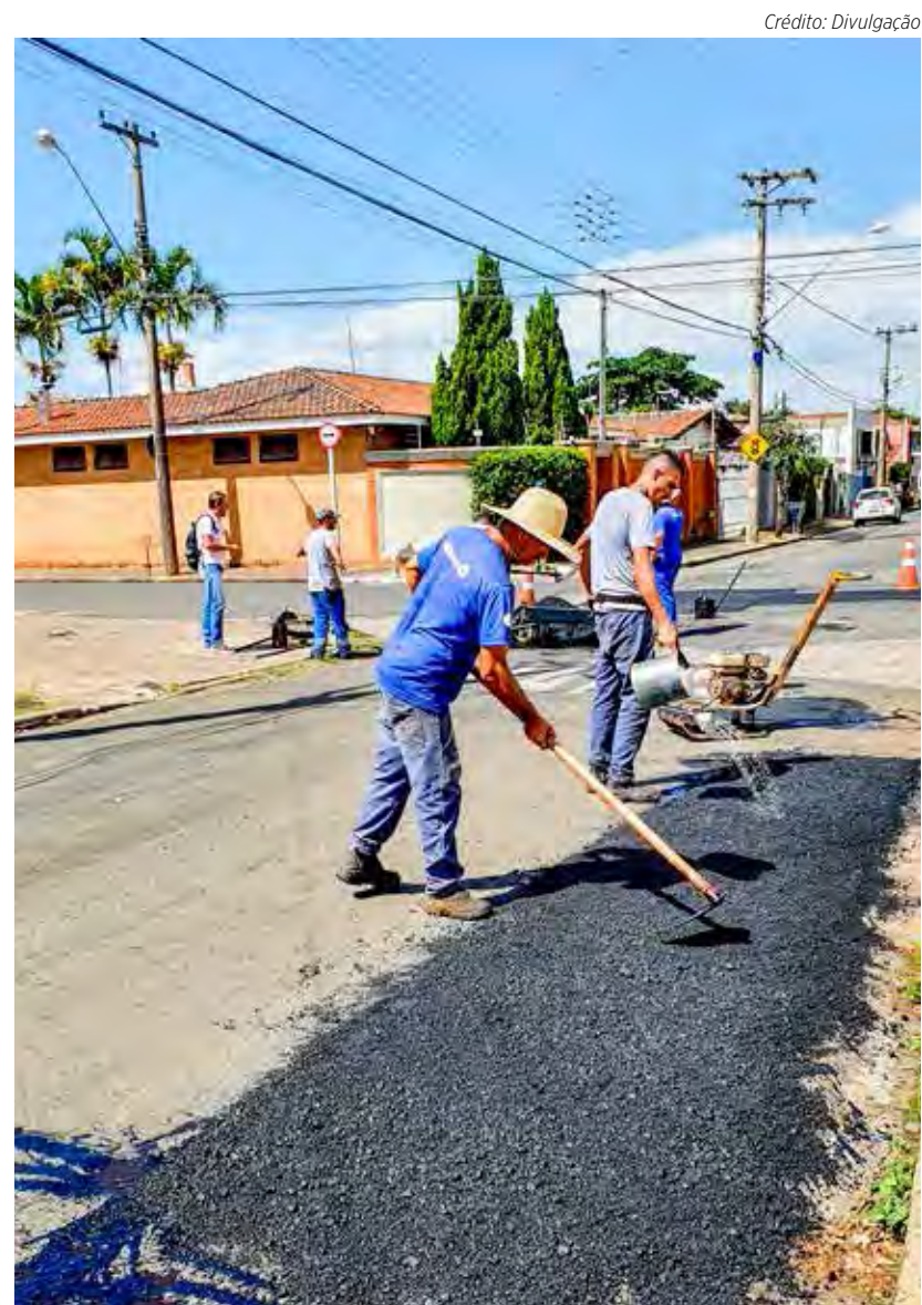
Serviço de reparo asfáltico em trecho de via
