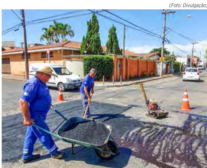
Serviço de reparo asfáltico em trecho de via
