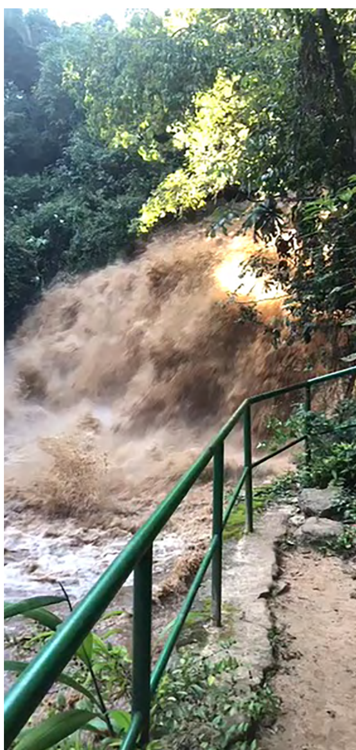
O rompimento de uma barragem em Analândia, ocorreu no domingo (20) e as águas atingiram o Rio Corumbataí
