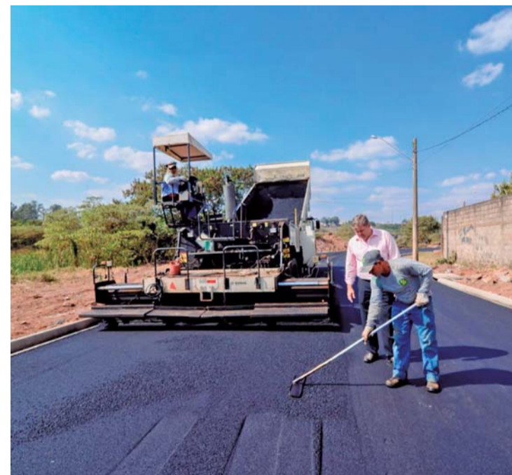
Trabalho semelhante está sendo realizado em ruas e avenidas do Grande Cervezeão
