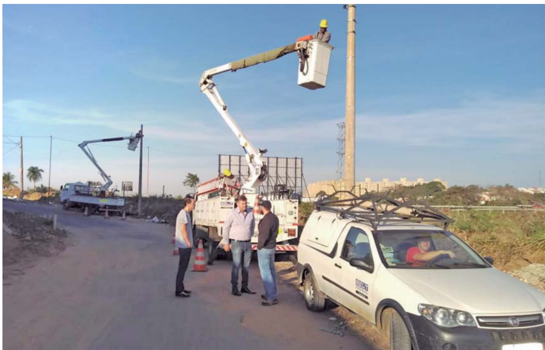
No local foram trocados três braços de iluminação e instalados outros três novos
